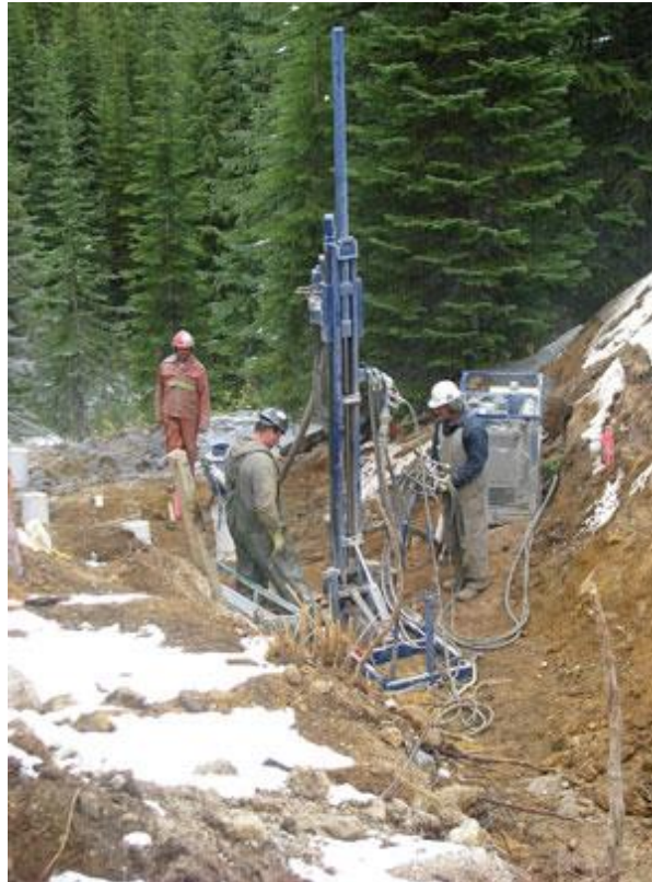
Figure 12: Exemple de petite foreuse qui peut être hélicoptérée. [Image tirée de http://northspan.ca/our-drills ]
