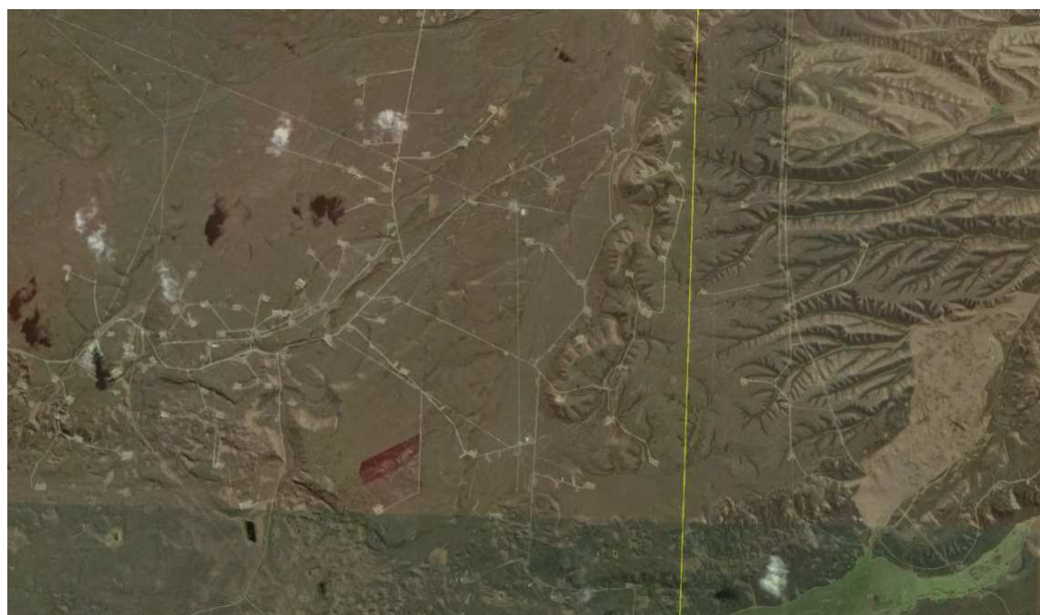
FIGURE 19 MULTIPLES PLATEFORMES DE FORAGE AU CENTRE DE PRODUCTION GAZIÈRE SUR L'ÎLE DE TERRE DE FEU 39
