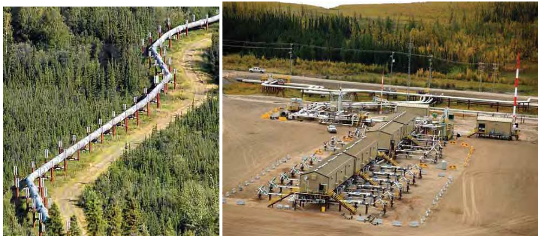
FIGURE 16 ILLUSTRATION D'UN PIPELINE EN MILIEU NORDIQUE ET D'UNE PLATEFORME DE FORAGE 29 .
