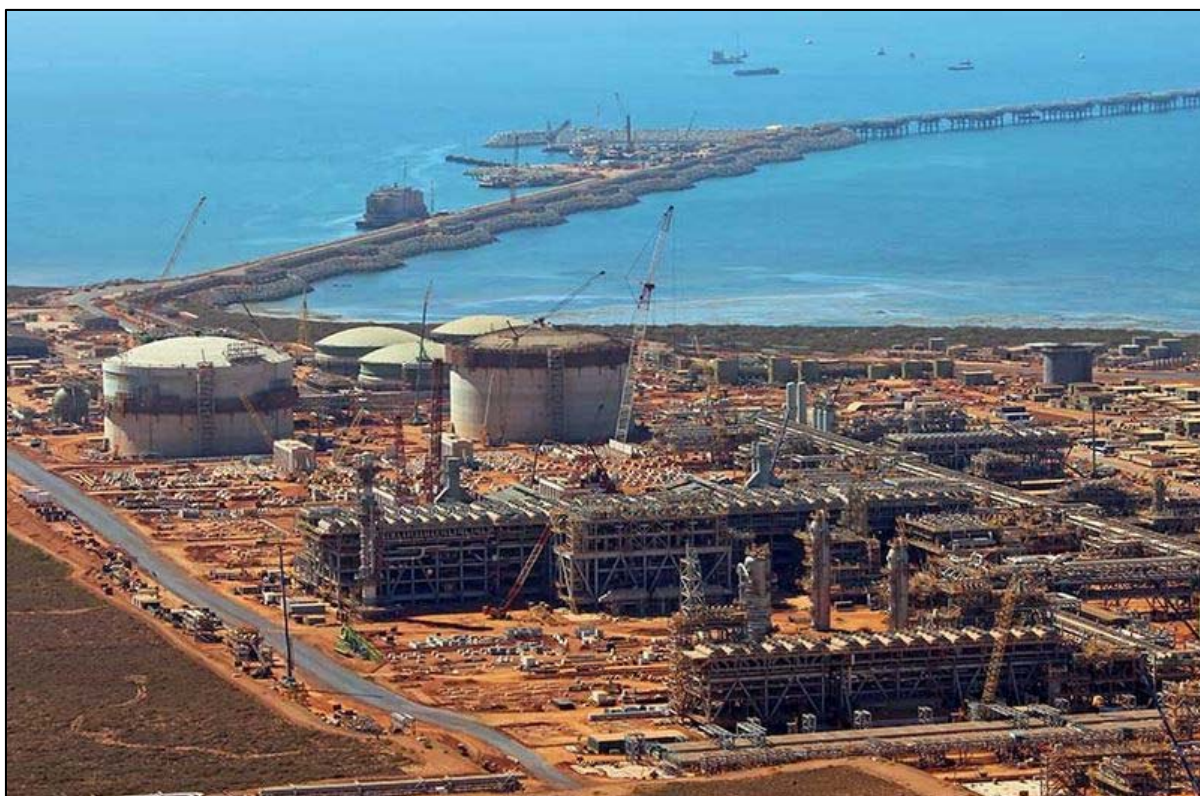
Figure 3.4 Usine de traitement des hydrocarbures, Gorgon, Australie.
